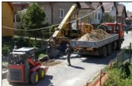
Práce na Novej ulici
