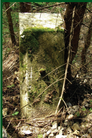
4. Stĺpik 22 km s kovovým meracím bodom na bolu, 2011
