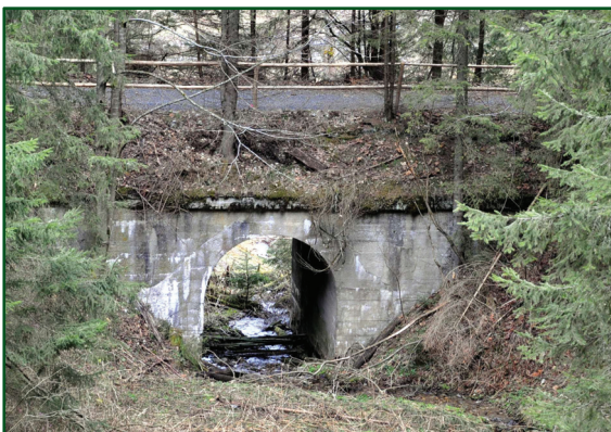
134. Malý viadukt medzi Čiernym Váhom a Benkovom. 18. 4. 2012
