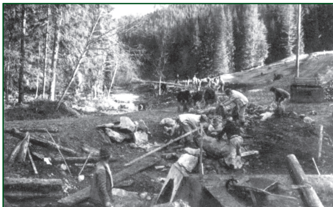
110. Výstavba trate lesnej železnice v doline Rovienky
