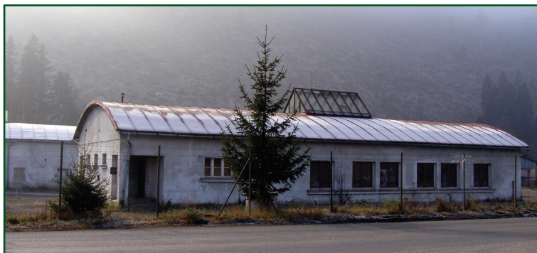
40. Budovy bývalého depa lesnej železnice, november 2011
