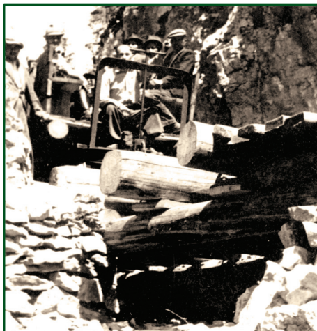
214. Stavba trate cez tiesňavu
