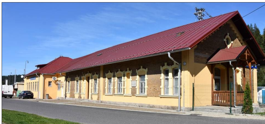
Zrekonštruovaná železničná stanica
