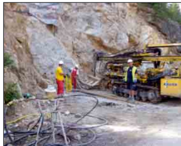
Injektáž ľavého údolného svahu
