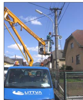
Rekonštrukcia miestneho rozhlasu
