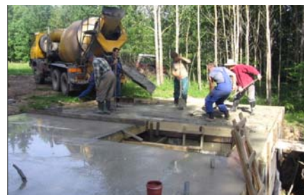
Zalievanie stropu suterénu betónom
