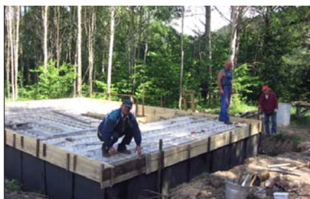
Montáž prefabrikátov na strope suterénu
