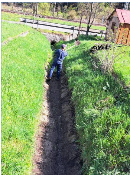
Úprava brehu Bocianky proti vybreženiu
