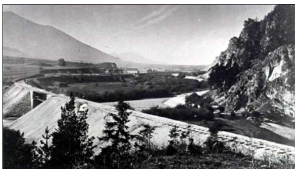
2. Stavba mosta na sútoku Bieleho a Čierneho Váhu, okolo r. 1895
