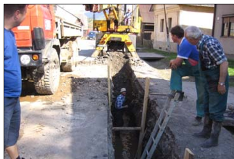
Výstavba kanalizácie v starej dedine
