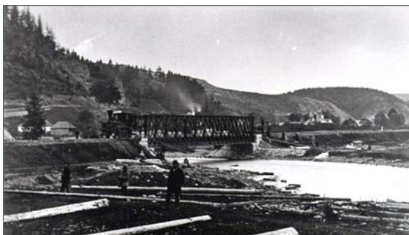
1. Stavba mosta ponad Váh pri Maši, 1870
